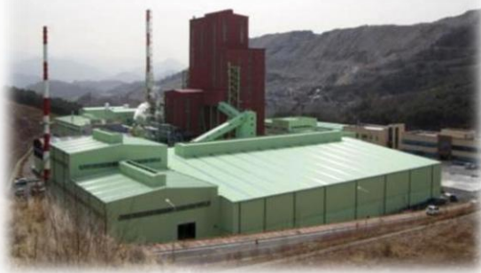
Copper Recycling GRM Danyang Smelter TSL (S. Korea)
