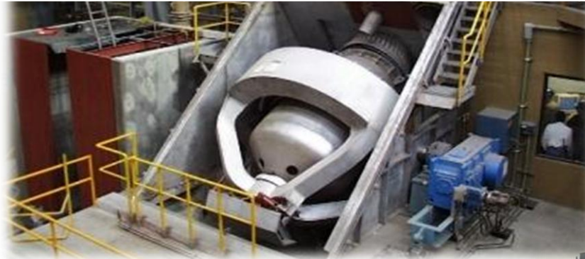
Boliden – Rönnskår Smelter Kaldo (Sweden)
